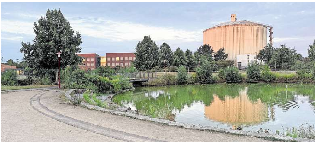
Regenrückhaltebecken im Hohnhorstpark.
