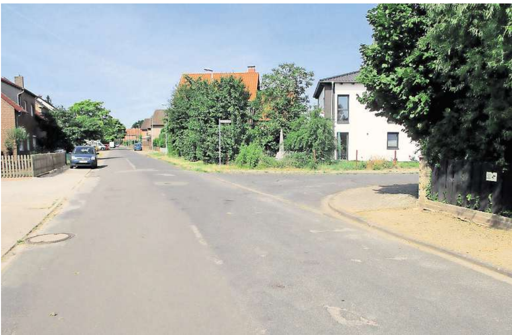
Zustand vor dem Ausbau: Die Straße Vor dem Heeßel an der Einmündung Stettiner Straße. Foto: Stadt Lehrte
