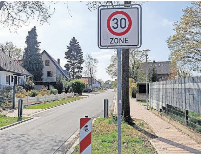
Mit Temporeduzierung und Fahrbahnverengung: Die Straße Vor dem Heeßel nach dem Ausbau. Foto: Stadt Lehrte
