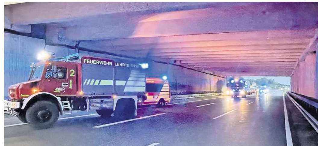
Einsatzstelle unter der Brücke im Autobahnkreuz Hannover-Ost.
