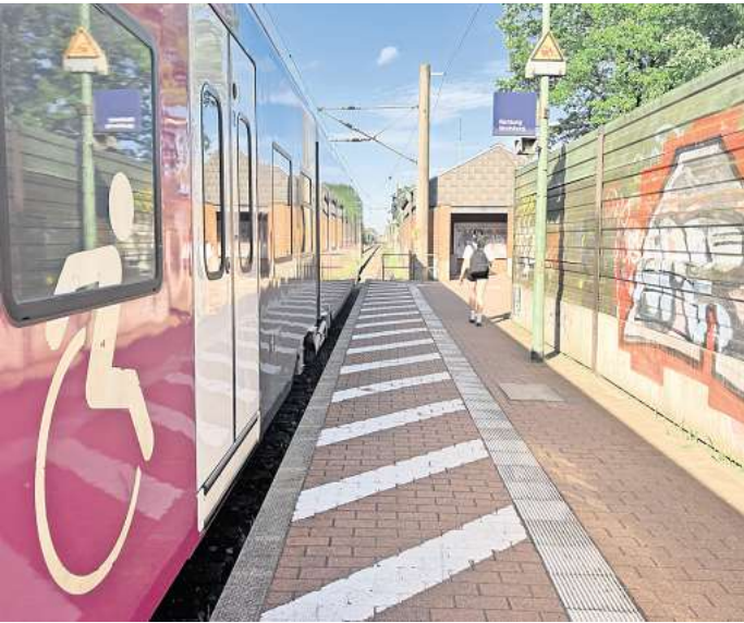
Barrierefreiheit und mehr Platz: Die Bahnsteige am Bahnhof Immensen-Arpke sollen ebenso erneuert werden wie Lärmschutzwände. Foto: Carina Bahl
