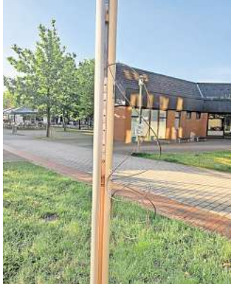
Vandalismus am Sehnder Rathaus: Die Seilzugeinrichtung für den Fahnenmast, an dem die Regenbogenflagge hing, ist beschädigt. Foto: Stadt Sehnde
