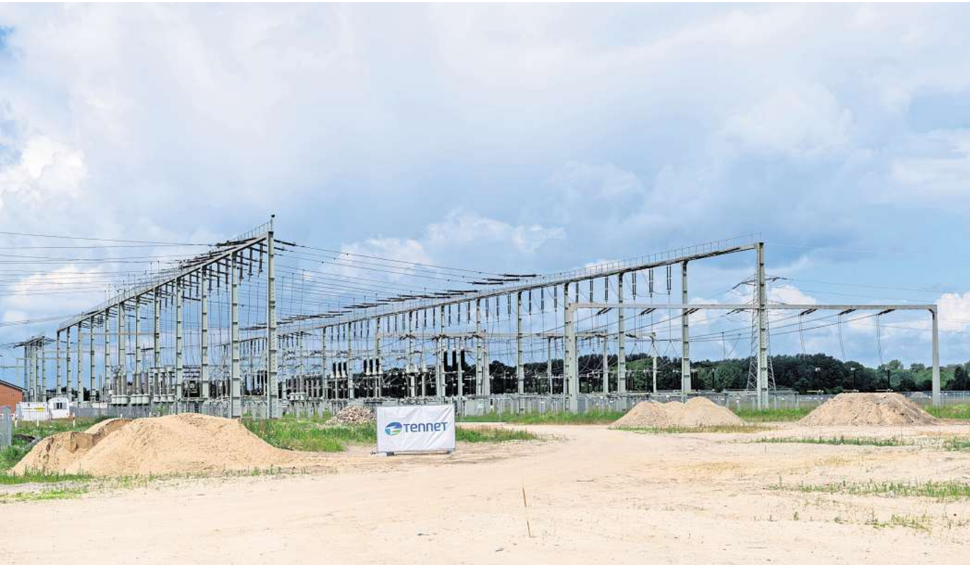
Das Umspannwerk in Ahlten: Die Baumaßnahmen haben begonnen.
