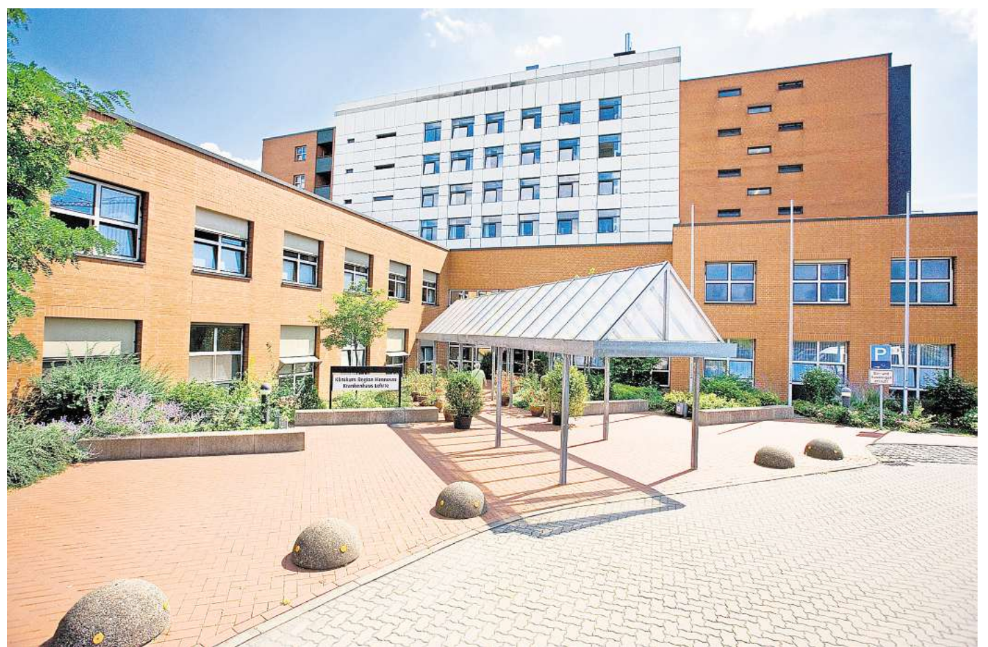
An der Manskestraße wird im KRH-Bestand ein neues Gesundheitszentrum aufgebaut.
