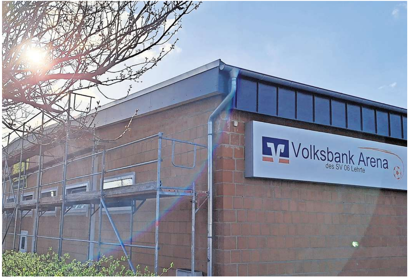
An der Mielestraße gibt es weitere Arbeiten für die energetische Sanierung.
