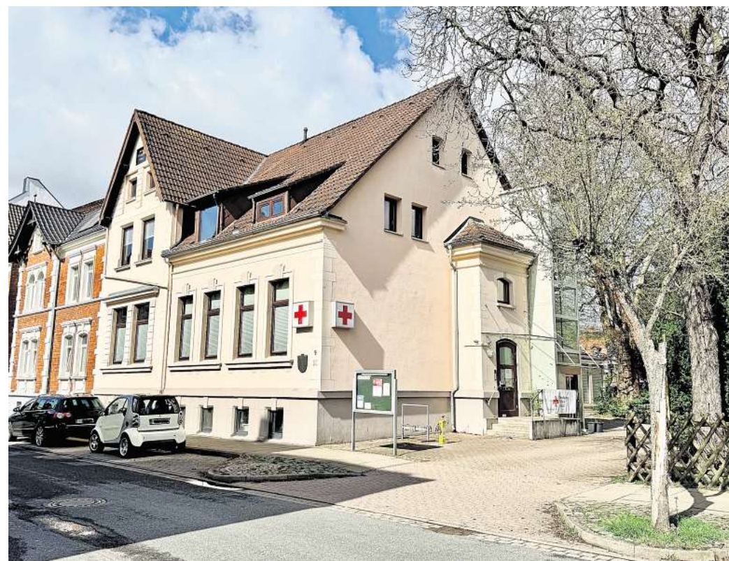
Vor 120 Jahren gebaut: Das DRK-Haus an der Ringstraße in Lehrte.
