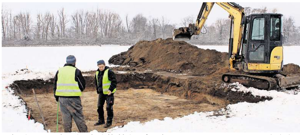
Vorbereitungen: In dem Viereck wird bald ein Trafo stehen.
