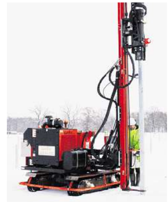
Ab in den Boden: Mit einer Ramme werden die Pfosten gesetzt. Foto: Michael Schütz
