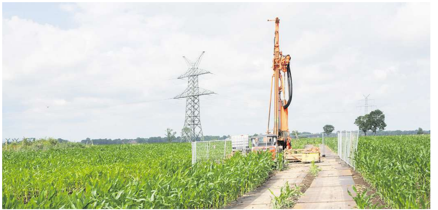
TenneT beginnt mit der Baugrund-Untersuchung.
