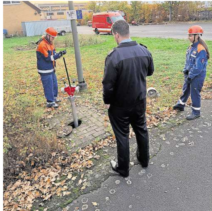
Prüfung zum Abzeichen Jugendflamme 2: Aufbau eines Standrohrs. Stadtfeuerwehr Sehnde
