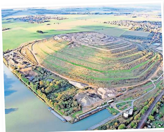
Einzigartige Festlocation: Die Kalihalde Friedrichshall in Sehnde ist seit Sommer 2022 vollständig abgedeckt.
