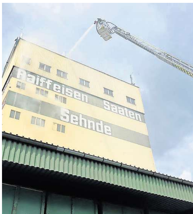
Einsatz der Feuerwehr an der Raiffeisenstraße. Foto: Stadtfeuerwehr Sehnde
