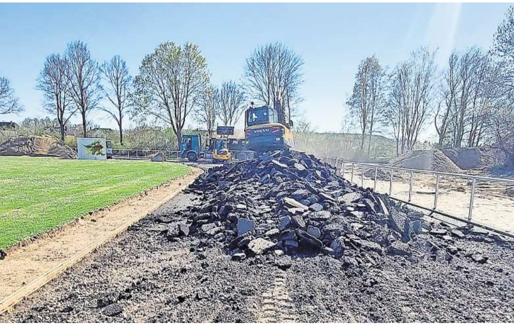
Alles muss raus: Der Untergrund der alten Tartanbahn wird entfernt und entsorgt. Foto: Stadt Sehnde
