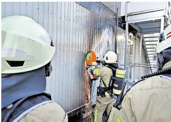
Öffnen der Wand zur Freilegung der Dämmung. Foto: Stadtfeuerwehr Lehrte
