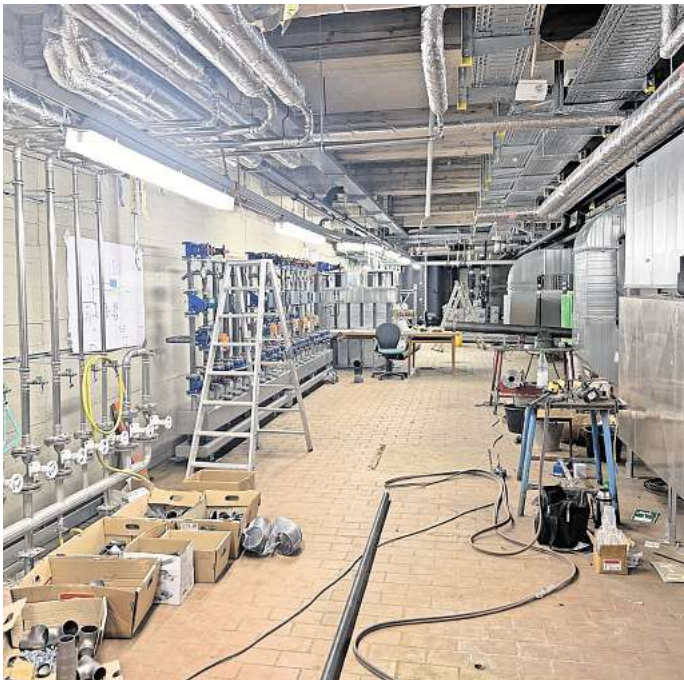
Im Heizungskeller: hier werden unter anderem neue Trinkwasserverteiler eingebaut.
