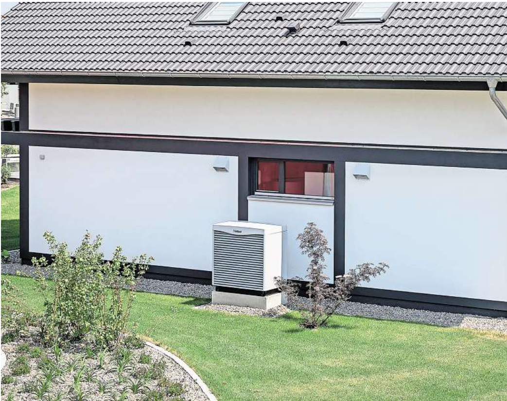
Die Luft-Luft-Wärmepumpe entzieht der Außenluft Wärme, um damit die Raumluft zu erwärmen. Foto: Daniel Maurer
