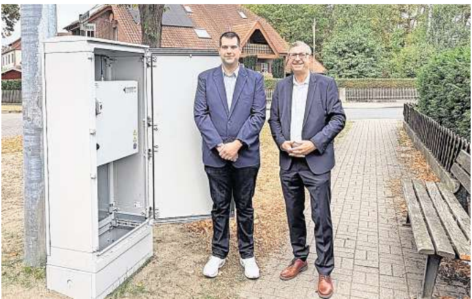
Die acht neuen Anlagen funktionieren: Bürgermeister Armin Pollehn (rechts) und Kersten Oliver Haas von der Herstellerfirma Sonnenburg Electronic AG beim Sirenentest in Burgdorf. Foto: Stadt Burgdorf
