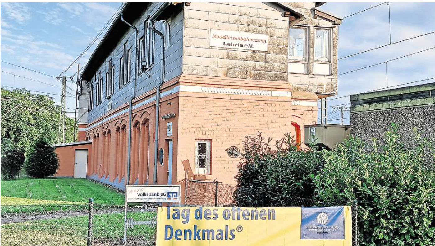
Besichtigung möglich: Das Museumsstellwerk an der Straße Richtersdorf.
