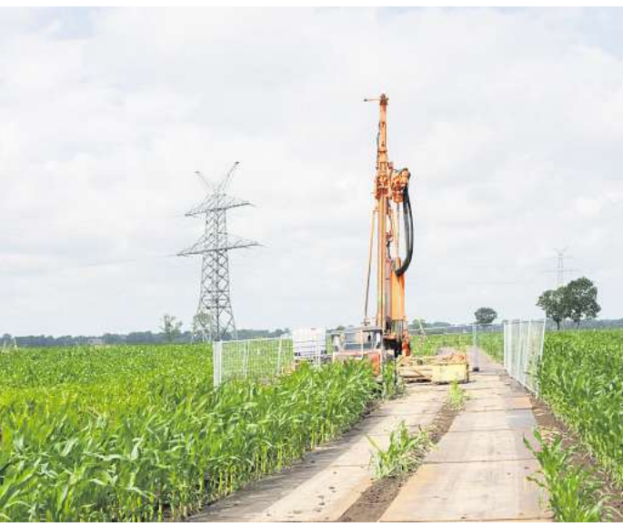
TenneT lässt den Baugrund für die neue 380-kV-Leitung untersuchen.
