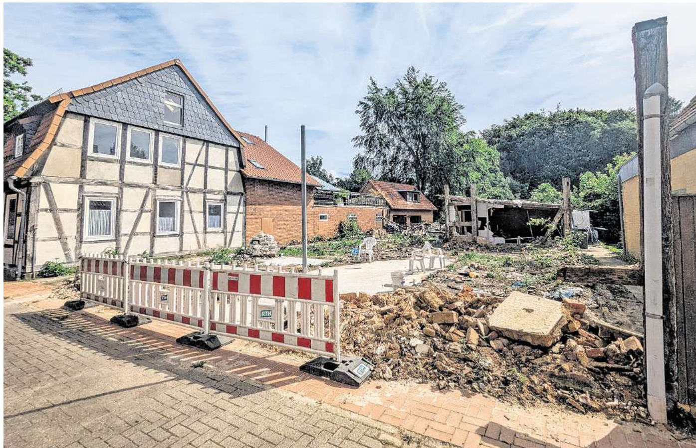
Baulücke Knickstraße 2: Das zuletzt baufällige Fachwerkhaus ist geordnet abgebaut worden.
