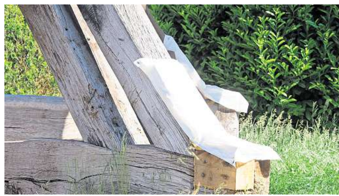
Das Corpus delicti: Anstückeln und Ausbessern verhilft dem maroden Balkenkopf der Kreuzstrebe nicht zur erforderlichen Stabilität. Foto: Martin Lauber
