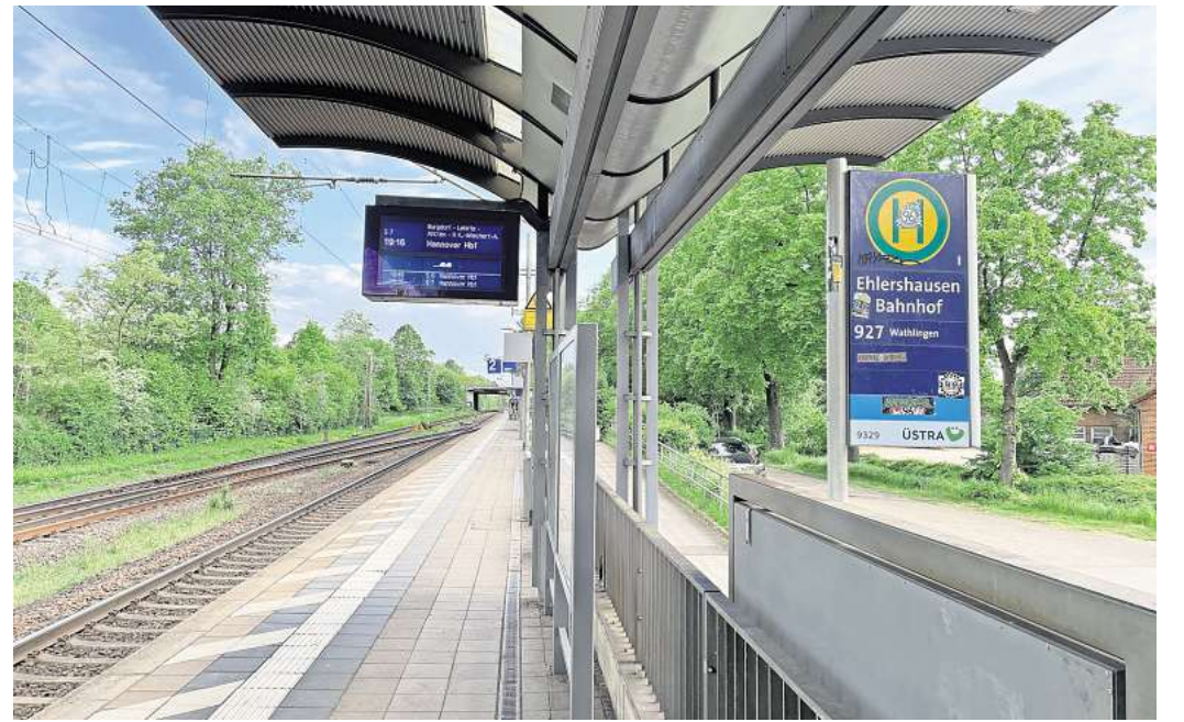
Bahnhof Ehlershausen Bahnsteig, Gleis Richtung Hannover.
