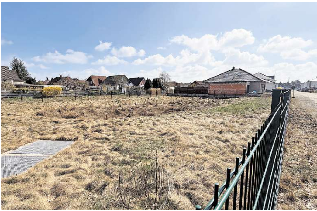
Überdimensioniert und damit deutlich teurer? Das Regenrückhaltebecken am Bienenweg in Uetze. Foto: Sven Warnecke
