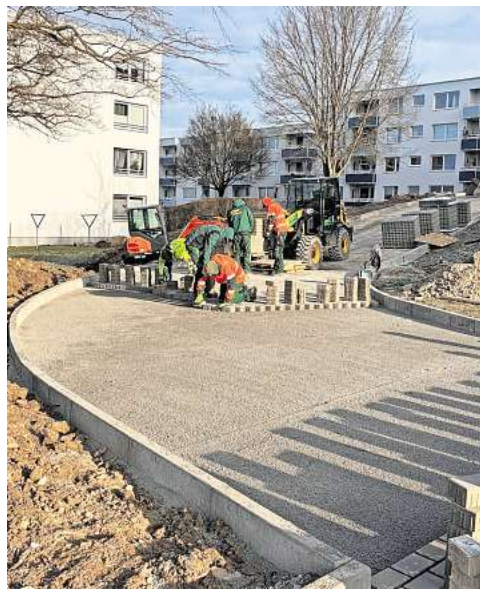
Für Pflasterarbeiten in größeren Projekten ist das ganze Team im Einsatz. Foto: privat
