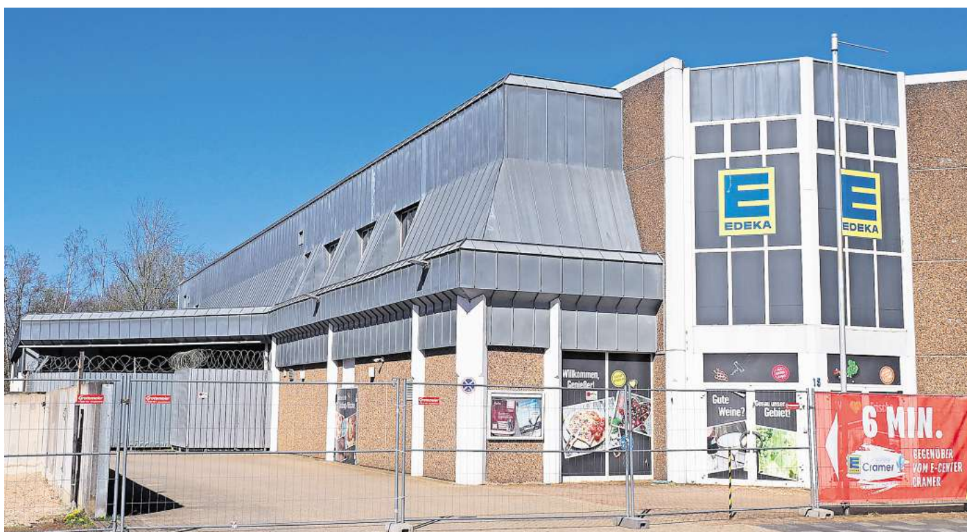
Abgeriegelt: Der alte Edeka-Cramer-Supermarkt an der Uetzer Straße ist seit August 2023 geschlossen.
