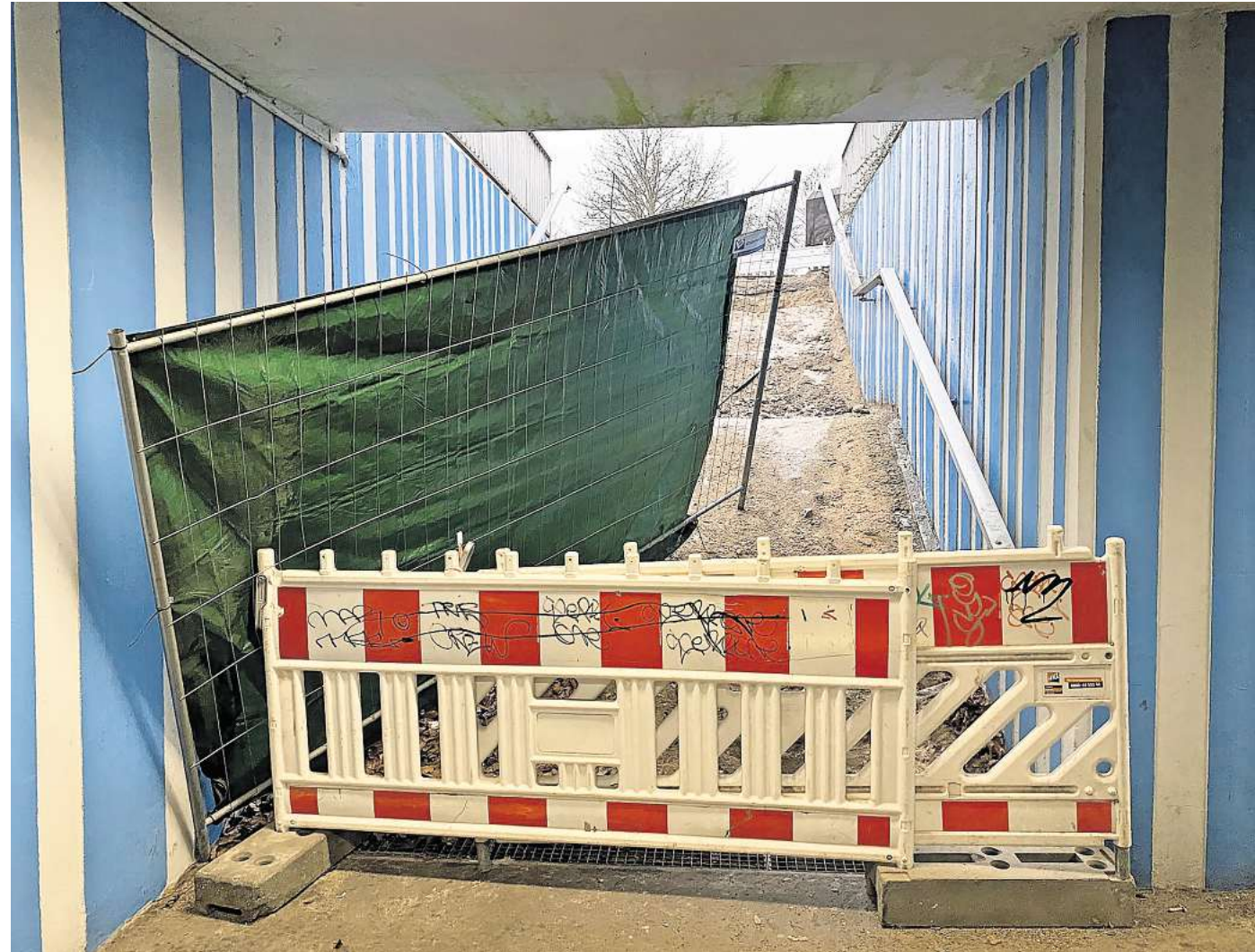
Abgesperrt: Die Treppe zur Weststadt am Bahnhof Burgdorf wird saniert.
