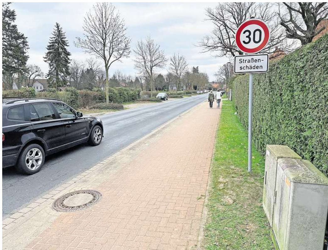
Angesichts der immensen Schäden auf Straßen im Uetzer Gemeindegebiet - hier in Hänigsen - hat die Verwaltung vielfach Tempolimits bis zur Sanierung angeordnet. Foto: Sven Warnecke
