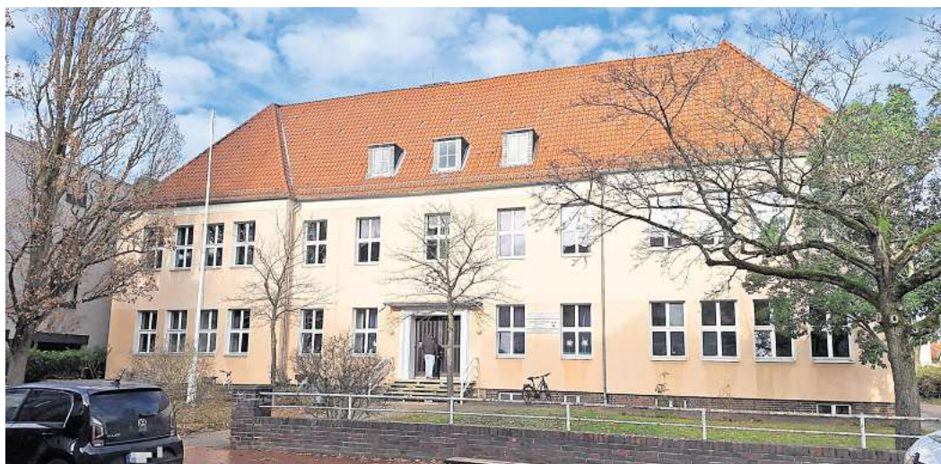
Die Stadt hat die Heizungsanlage der Ingo-Siegner-Grundschule instand gesetzt. Foto: Jakob Buddenbohm
