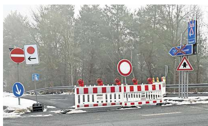
Die A37 im Bereich Burgdorf wird noch bis August 2026 saniert. Deshalb ist die Auf- und Abfahrt Burgdorf-Kolhorn noch gesperrt. Foto: Andreas Voigt
