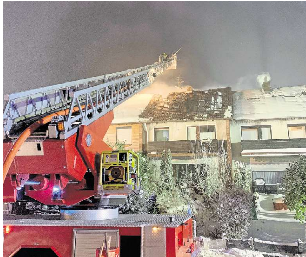
In einem Reihenhaus brennt der Dachstuhl: Gut 60 Feuerwehrleute eilen zum Einsatzort an den Sandkuhlenweg nach Hänigsen. Foto: Feuerwehr Uetze
