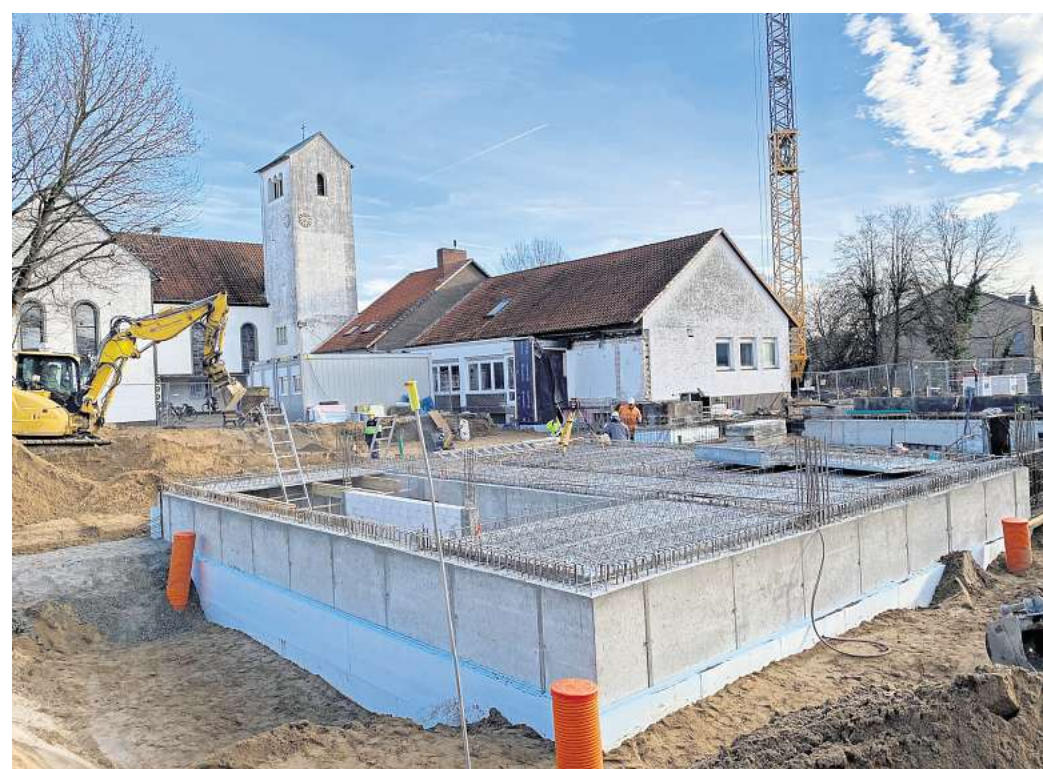
Das Fundament ist gegossen, der Grundstein gelegt: Bis Frühjahr 2027 dauert die Errichtung der St.-Nikolaus-Kita. Foto: Katerina Jarolim-Vormeier
