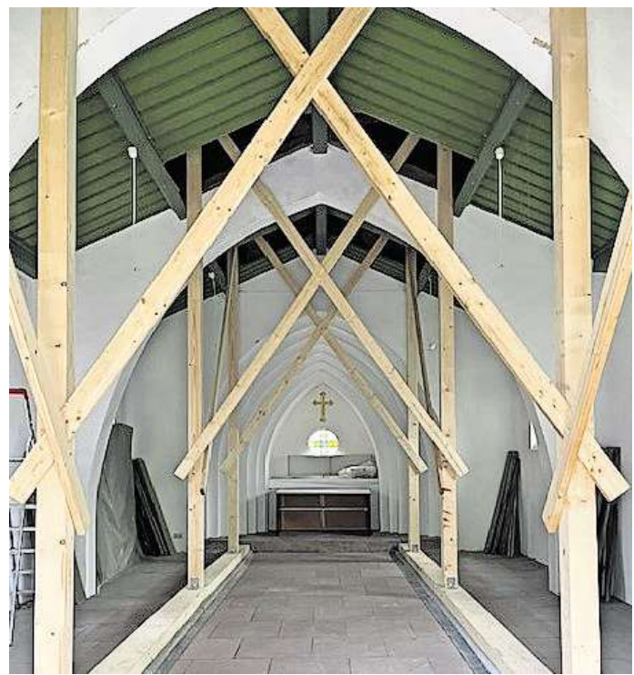
Mit einer Stützkonstruktion hat die Stadt die Magdalenenkapelle innen gesichert.
