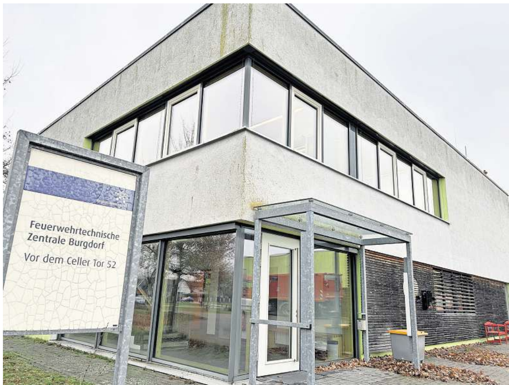
Zu klein: Die Feuerwehrtechnische Zentrale (FTZ) in Burgdorf von 2009 genügt den Ansprüchen ans moderne Feuerwehrwesen nicht mehr.
