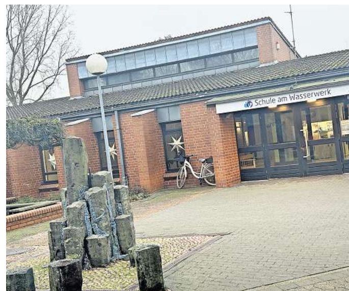
Der bisherige Standort der Schule am Wasserwerk entspricht nicht mehr den Anforderungen. Foto: Andreas Voigt
