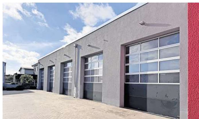
Sieht schon gut aus: Das ist die Rettungswache von außen.
