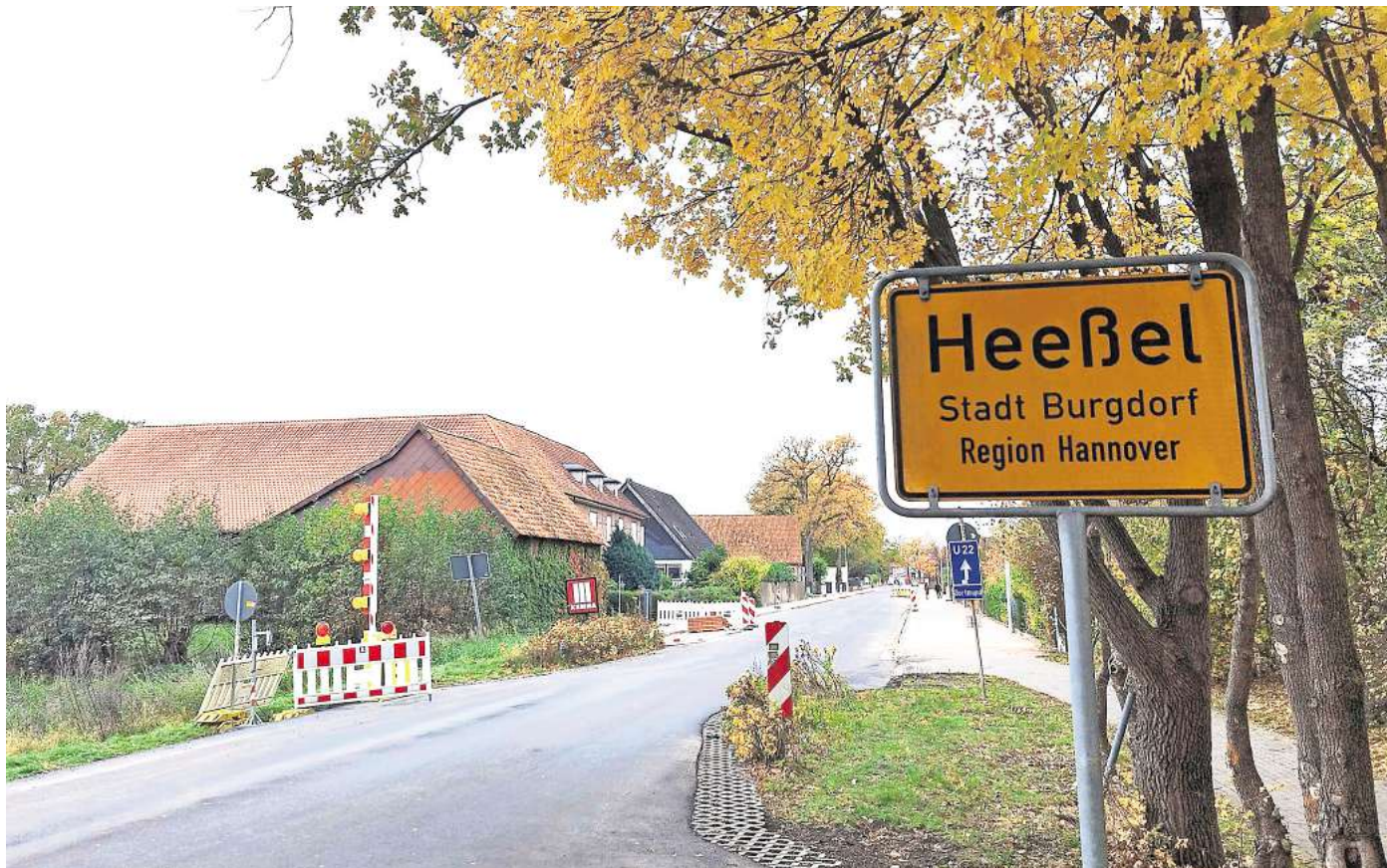
Die Ortsdurchfahrt in Heeßel ist wieder freigegeben.
