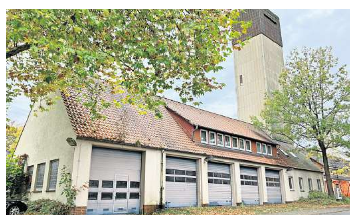
2027 soll gebaut werden: Auf dem Gelände der leerstehenden Feuerwehrtechnischen Zentrale am Marris-Mühlenweg sollen Sozialwohnungen entstehen. Foto: Emily Bader
