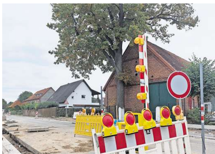
Asphaltierungsarbeiten: Vom 20. bis 24. Oktober wird keine Schranke geöffnet sein – dann gilt eine komplette Vollsperrung. Auch Busse dürfen nicht fahren. Foto: Carina Bahl
