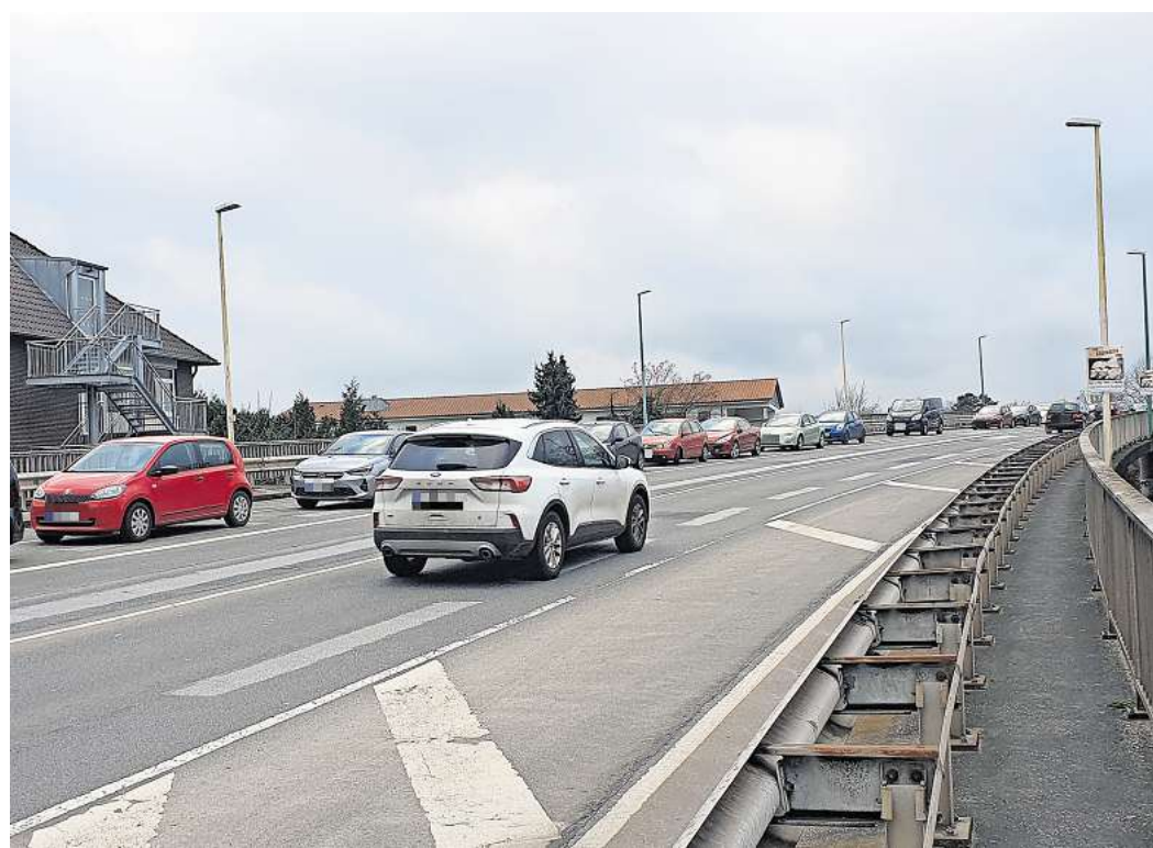
Darin ist sich die Politik einig: Eine Sperrung der Hochbrücke, die als Zubringer zur Innenstadt dient, wäre fatal. Foto: Sandra Köhler
