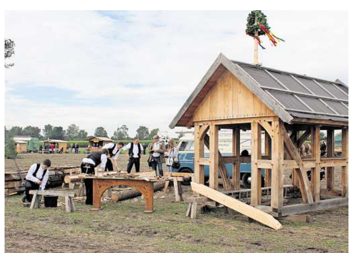
Die Besucher erleben, wie Zimmerer das Holz zu Balken verarbeiten und ein Fachwerkhaus errichten. Foto: privat
