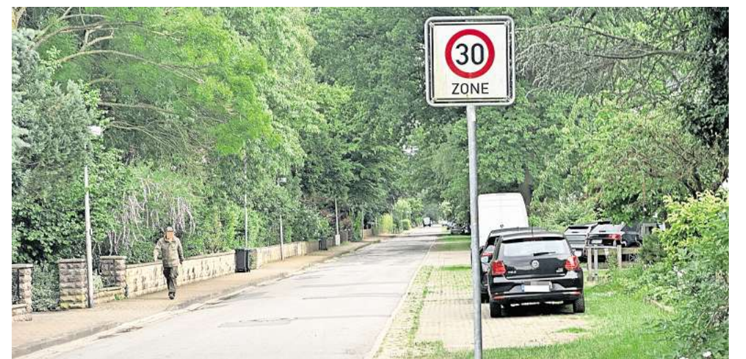
Geschwindigkeitslimit soll fallen: Um vom Land Niedersachsen einen Zuschuss für die grundlegende Sanierung der Straße Am Fließgraben zu erhalten, soll die Tempo-30-Zone aufgehoben werden.
