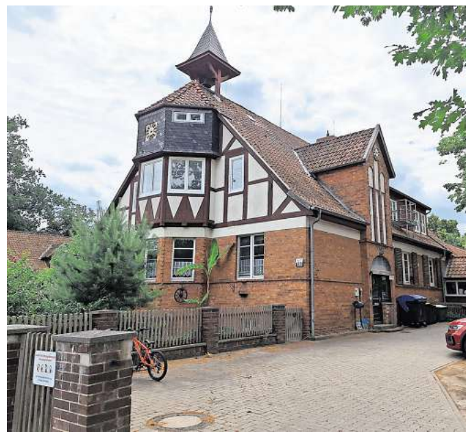
Rund 100 Jahre alt: Das ehemalige Schulgebäude an der Katenser Hauptstraße stand elf Jahre lang leer, ehe die Kita einzog.
