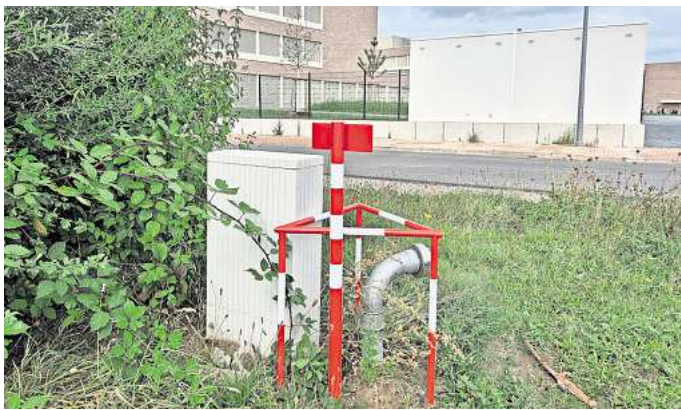
Nah dem IGS-Neubau befindet sich ein neuer Löschwasser-Brunnen. Foto: Stadt Burgdorf
