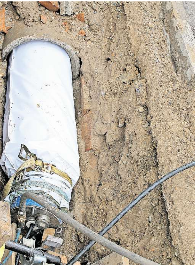
Wo es möglich ist, kommt ein grabenloses Verfahren zum Einsatz. Dabei wird ein sogenannter Schlauchliner in die vorhandenen Rohre eingezogen.
