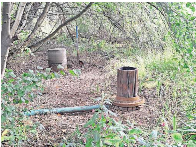
Die Wasserrechte sind ausgelaufen: Aus dem vorderen Brunnenring sprudelten früher bis zu 138.000 Kubikmeter Grundwasser pro Jahr. Foto: Frank Walter
