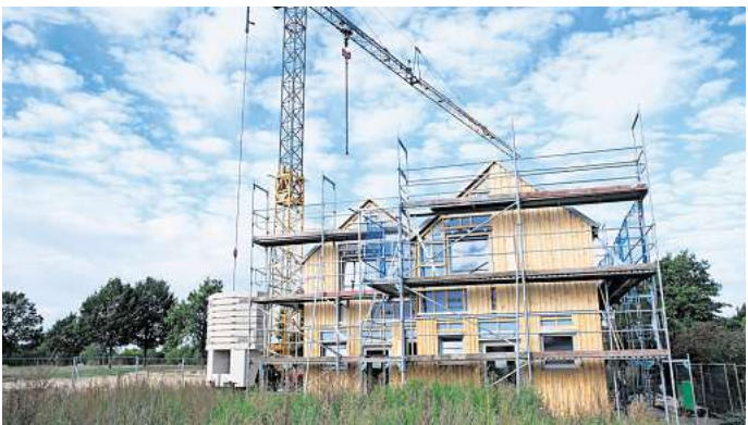
Es geht voran: Das erste Muster-Doppelhaus der Wohnsiedlung im Kornfeld ist in wenigen Monaten fertiggestellt. Foto: Josefine Battermann
