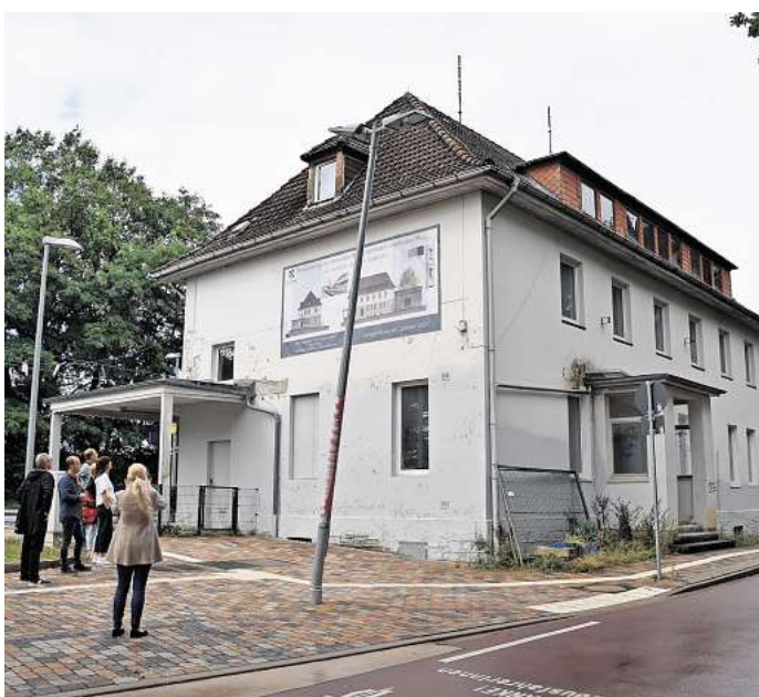
Rund 360 Quadratmeter Nutzfläche plus Keller und Dachboden: das Bahnhofsgebäude. Foto: Frank Wa
