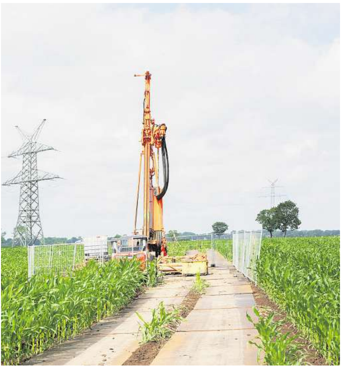
Baugrunduntersuchungen für die neue 380-kV-Leitung: TenneT setzt die Arbeiten nun in Isernhagen und Burgwedel fort. Foto: TenneT Germany
