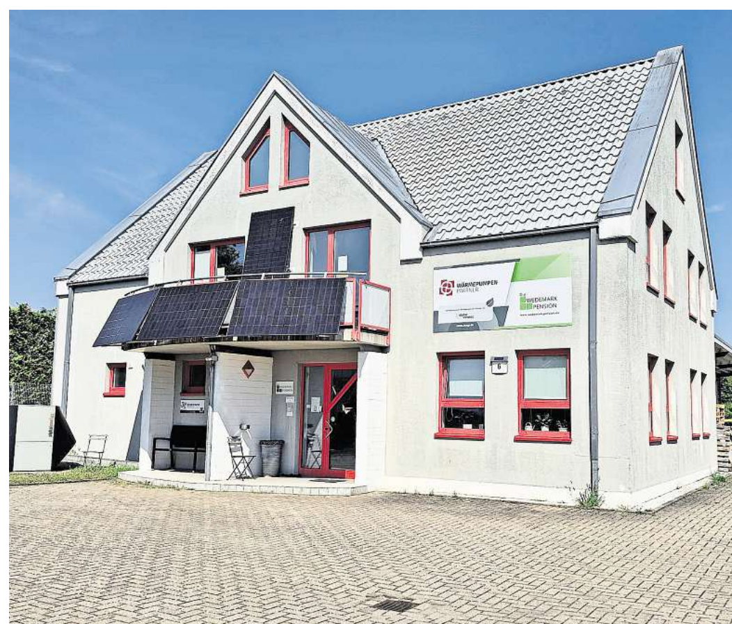
Im Gewerbegebiet an der Industrieweg in Mellendorf ist der Firmensitz des „Wärmepumpenpartners“ zu finden.
